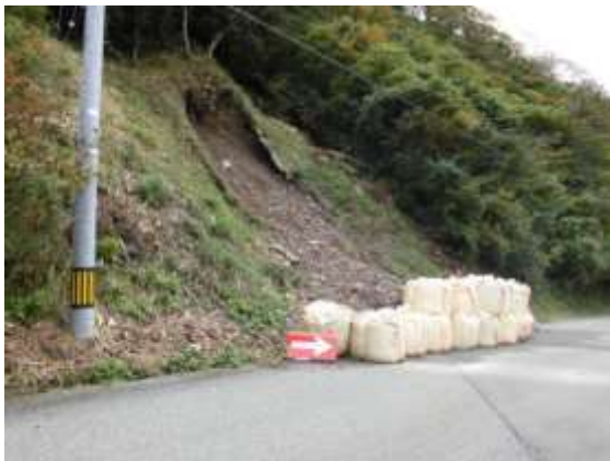
2013.10.22.時点のコースのり面崩落の写真
